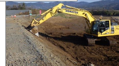
【MC建機】掘削状況
