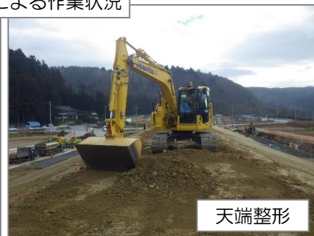
MCバックホウによる作業状況
