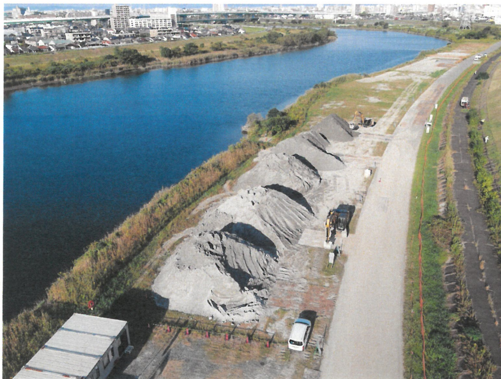
仮置き of 浚渫土
