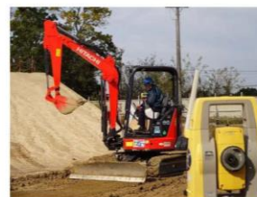
3DマシンコントロールPATブレードによる施工
