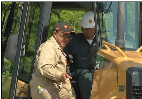
盛土敷均し 3D-MCブルドーザ
