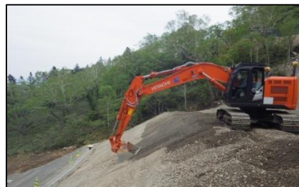
盛土法面整形 3D-MGバックホウ
