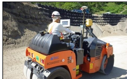
盛土転圧 GNSSアンテナ搭載振動ローラ
