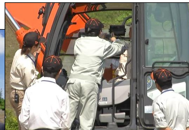
盛土法面整形 3D-MGバックホウ
