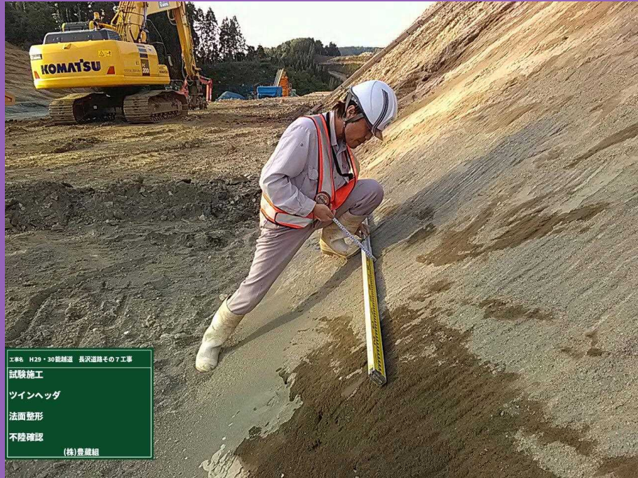
ツインヘッドの不陸状況(平均10mm)
