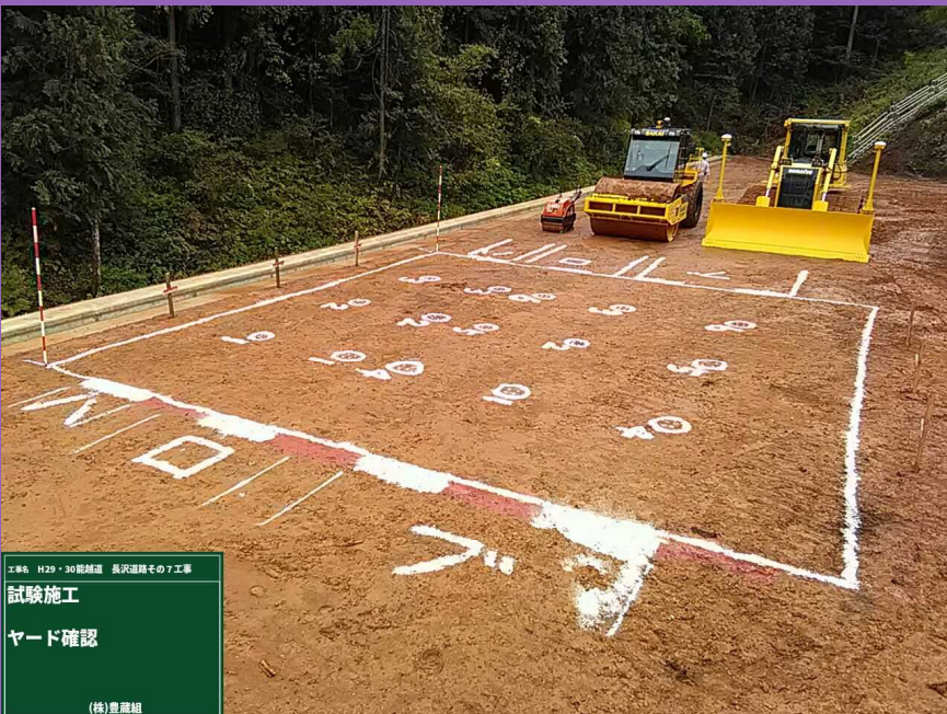
試験施工状況
