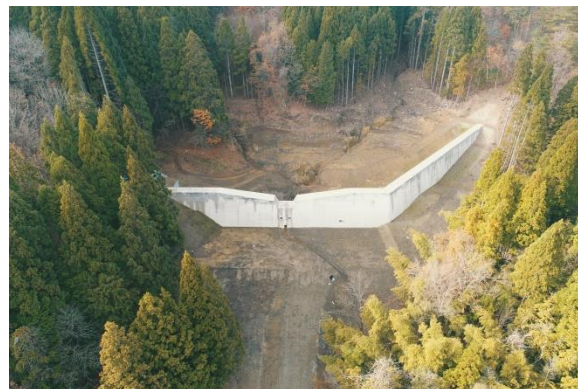
完成写真② 下流から上流側を撮影
