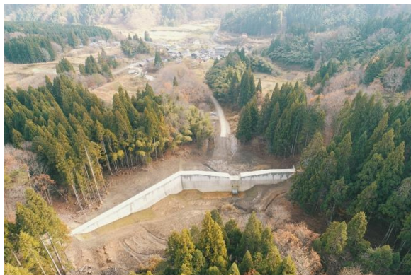
完成写真① 上流から下流側を撮影
