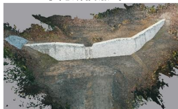
工事完成後点群データ
