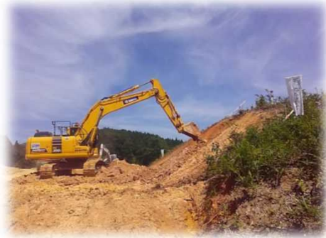
ICT建機 掘削状況
