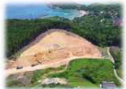
UAV(ドローン測量)状況
