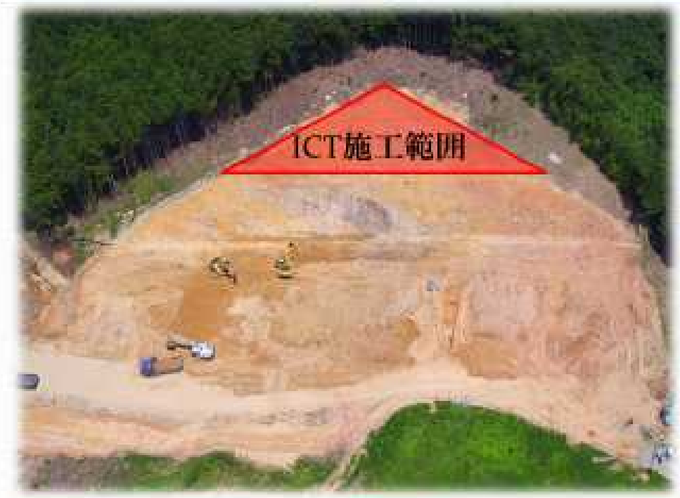
UAV(ドローン測量)状況
