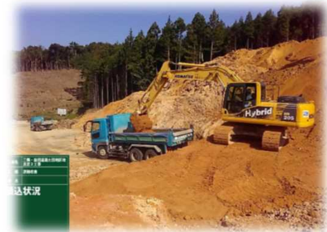
掘削土積み込み状況
