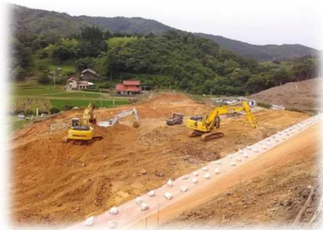
全体施工状況
