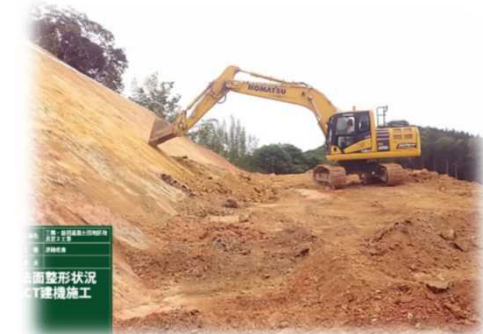
ICT建機法面整形状況
