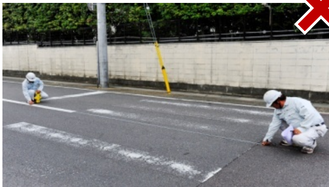
建設業の課題（危険作業）
