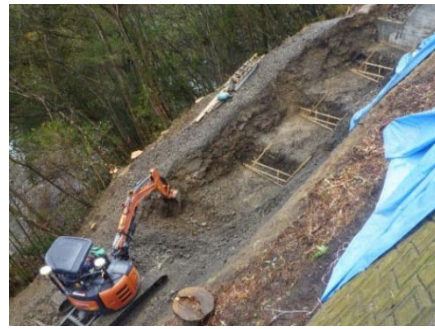
ICT建機による掘削作業
