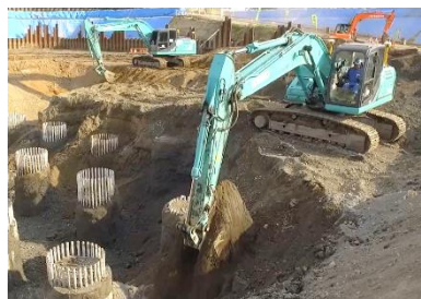
MCバックホウによる水門掘削
