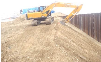
MGバックホウによる法面整形
