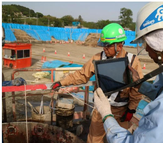
専用ソフトが入ったタブレットでの工事写真撮影
