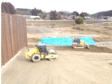
MGブル、GNSSロ-ラによる敷均し・転圧
