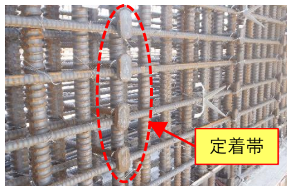
機械式定着鉄筋の配置
