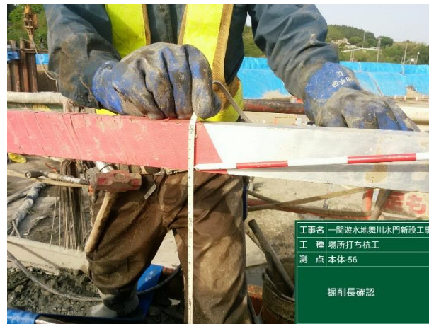
電子黒板入り工事写真
