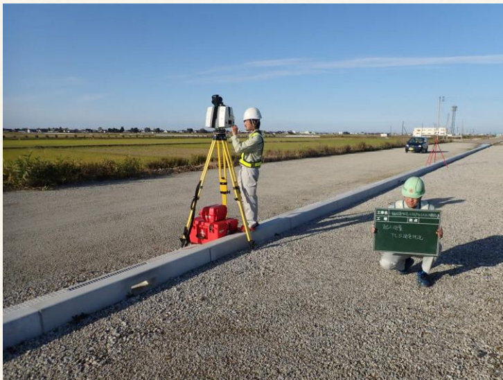
3次元起工測量(TLS)
