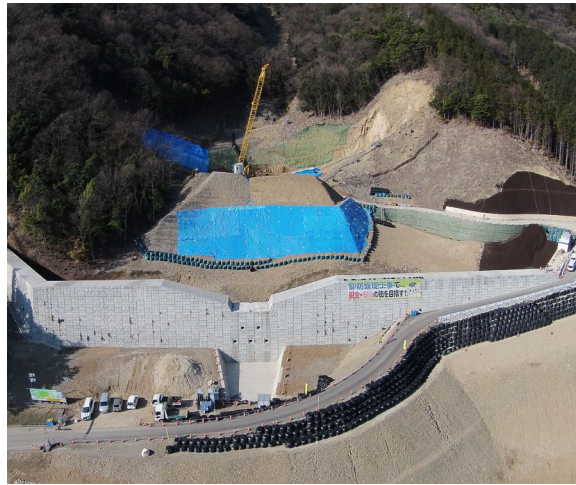
仮設ヤード完成
