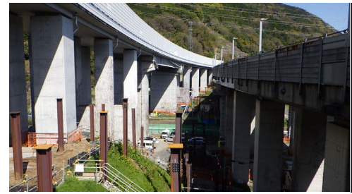
現場状況（高速道路橋梁）
