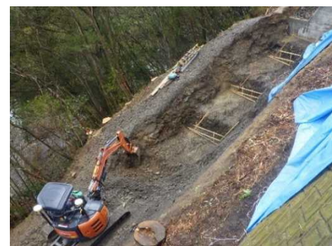
ICT建機による掘削作業
