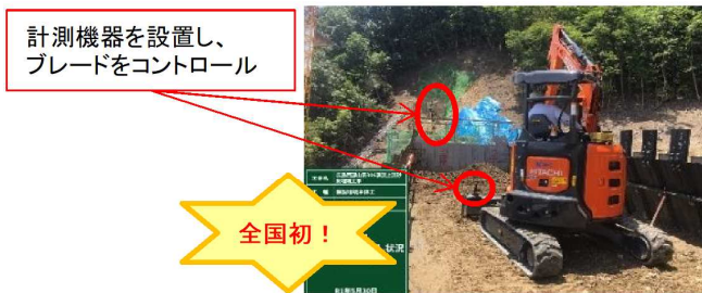
【ICT建機による本堤内部材敷均し】
