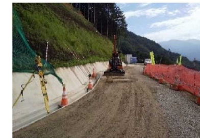
【ICT建機による路盤敷均し】
