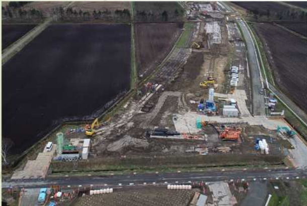
地上部作業状況
