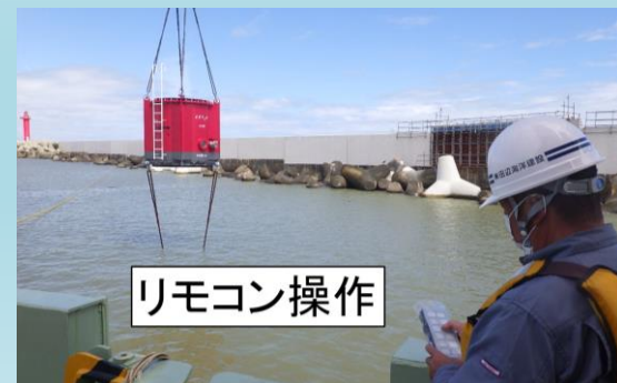
遠隔吊荷制御装置によるブロックの向き調整
