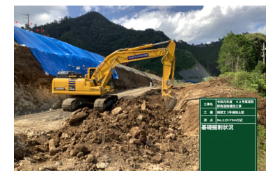
擁壁基礎の床堀 (丁張りなし)
