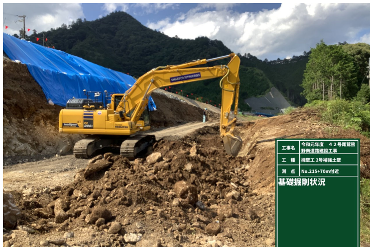
擁壁基礎工におけるICT施工(丁張りなし)
