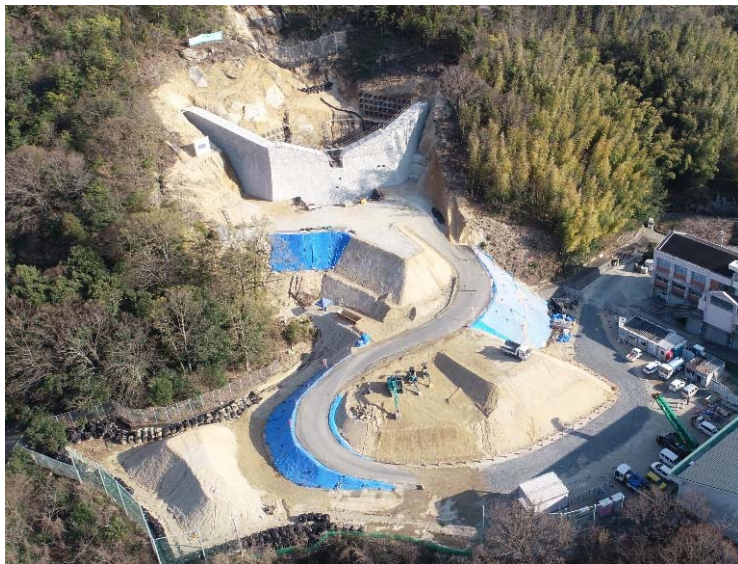
【工事着手時現況空撮 R2年4月】
