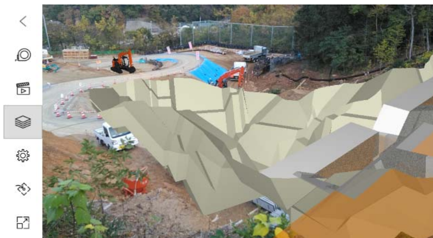
【掘削・床掘 AR】
