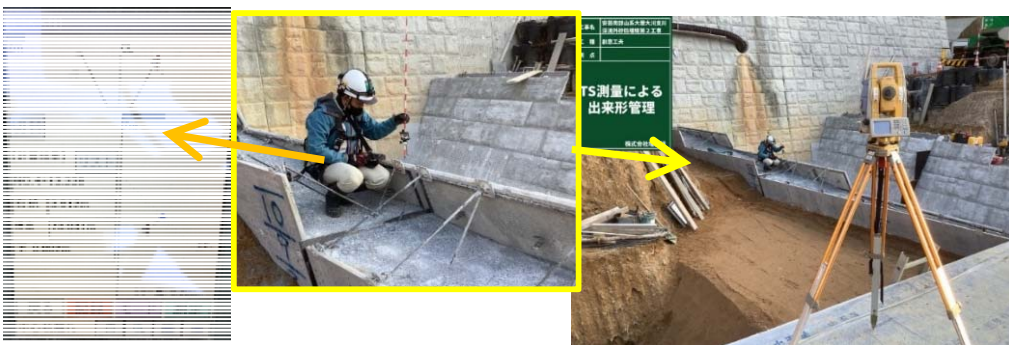
【構造物TS測量状況】
