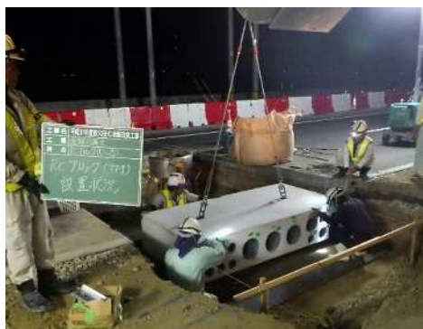
今回取組施工状況写真
