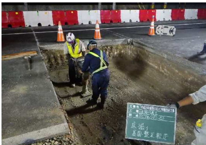
基面整正・転圧状況写真
