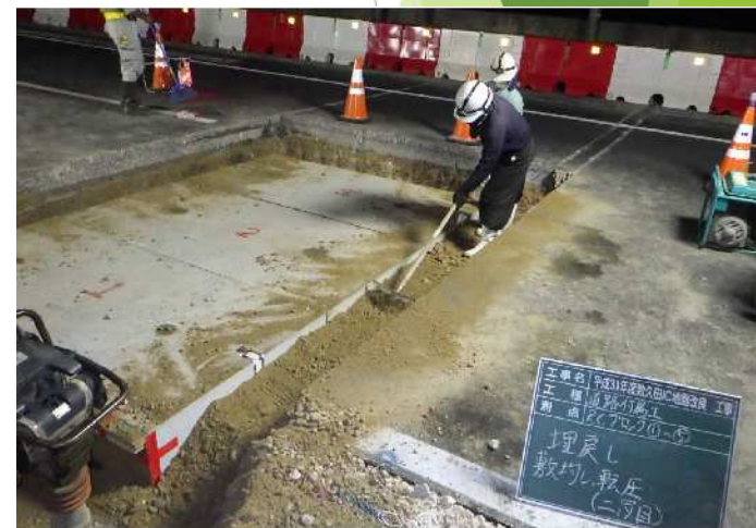
埋戻し・転圧状況写真
