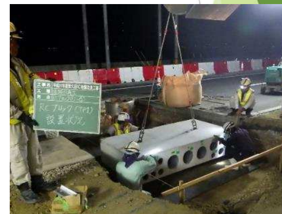
今回取組施工状況写真
