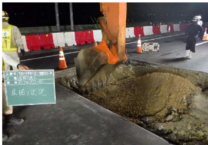
床掘り状況写真
