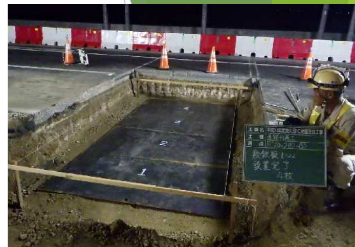
鉄板敷設状況写真
