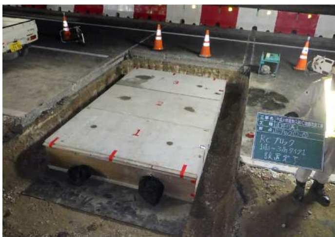
3函設置完了状況写真
