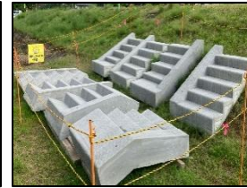
階段部材造形完了
