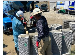
中詰コンクリート打設
