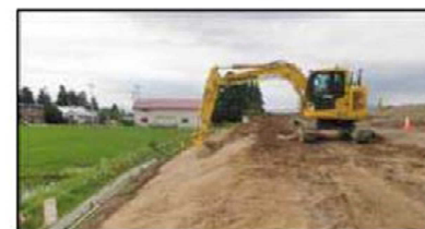
ICTバックホウによる法面整形
