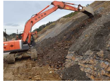
長大法面・流れ盤での掘削
