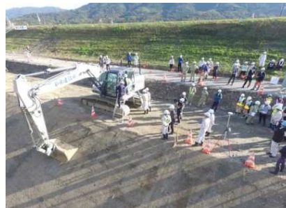
3DMGバックホーによる法面整形
