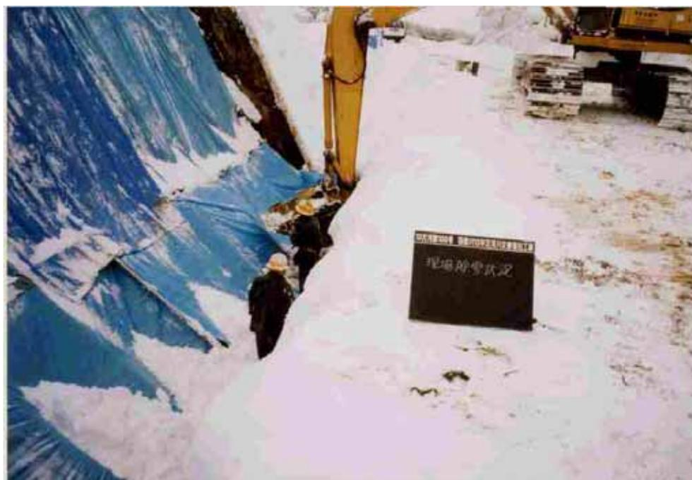
掘削底部の除雪はバックホウと人力の併用
