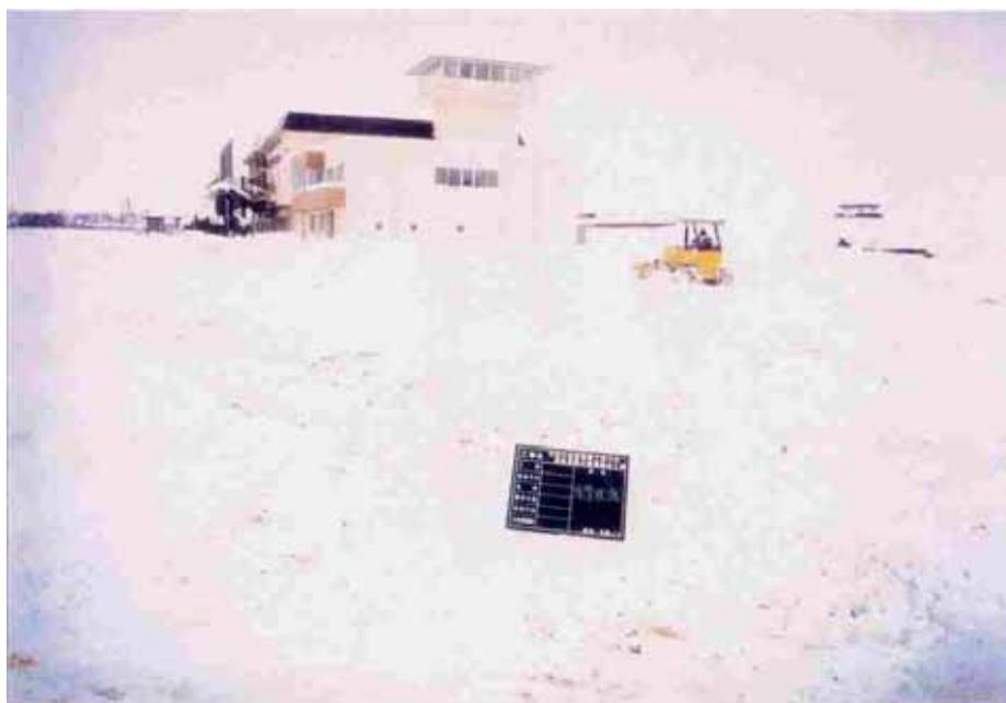
堤内側 5t 級ブルドーザにて除雪
