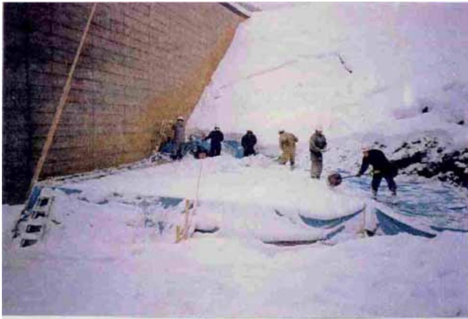
工事中シートにて覆った箇所の除雪作業状況
