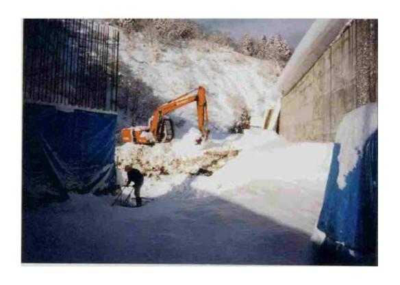
工事用道路機械除雪、構造物付近人力除雪作業状況
