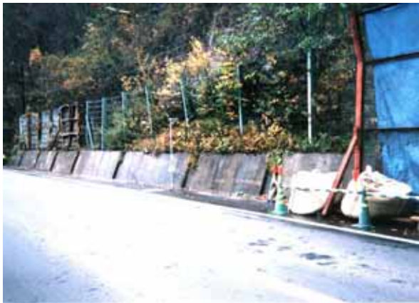
写真 1 施工前の状況
