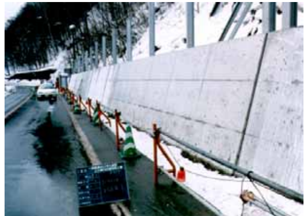
写真 2 施工後の状況
