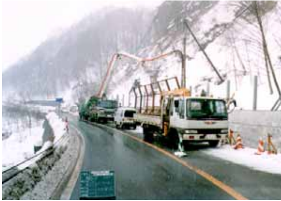
写真 3 コンクリート打設状況
