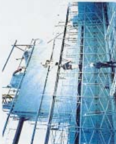
手すりわりく取り付け
