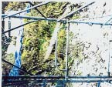
裏側手すりわりく取り付け完了
