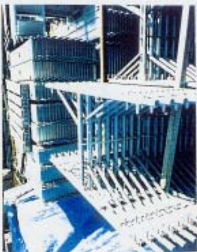
材料搬入状況
