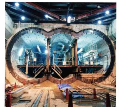
地下鉄の建設（3 連シールド工法）
