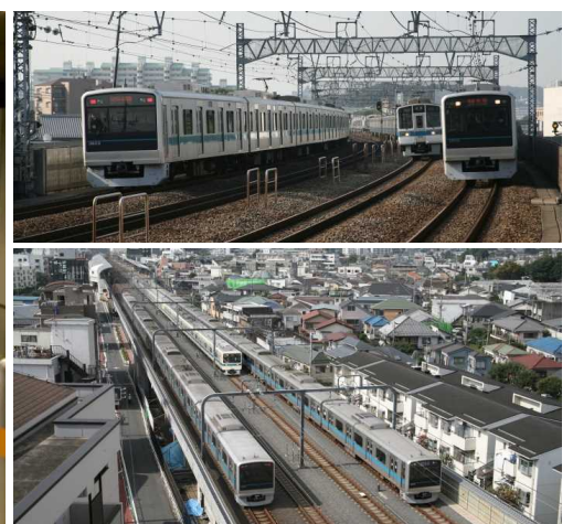
複々線化と立体化が完成した区間
