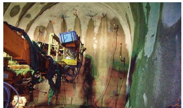
写真 薬液注入工の施工例
