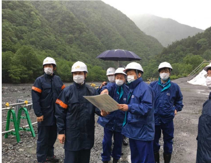
さわらじま 榎島ヤード(非常口)
