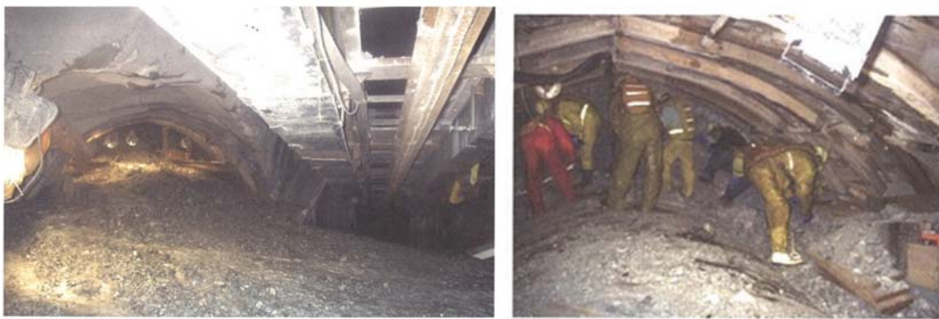
写真3 飛騨トンネルTBM土砂崩落復旧状況
