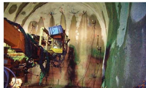
写真 薬液注入工の施工例
