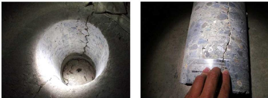
インバートコンクリートの上部のクラック幅2.0mm、下部のクラック幅1.6mmを確認(加賀トンネル北工区)
