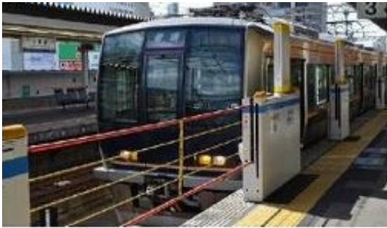
昇降ロープ式ホーム柵
