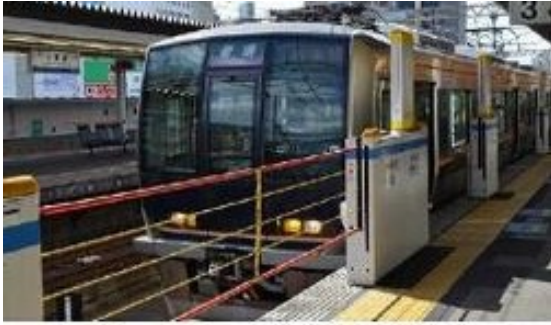
昇降ロープ式ホーム柵
