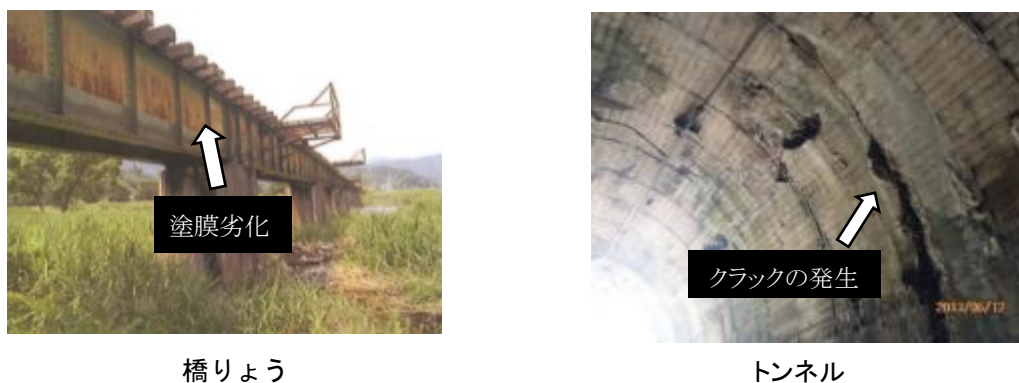
図4：老朽化が進んでいる施設の例
