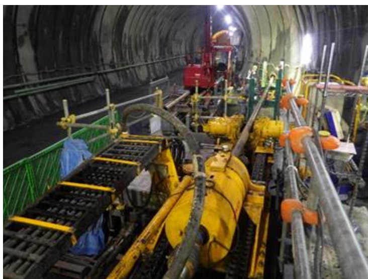
図 4.3 高速長尺先進ボーリング施工写真（山梨工区）
