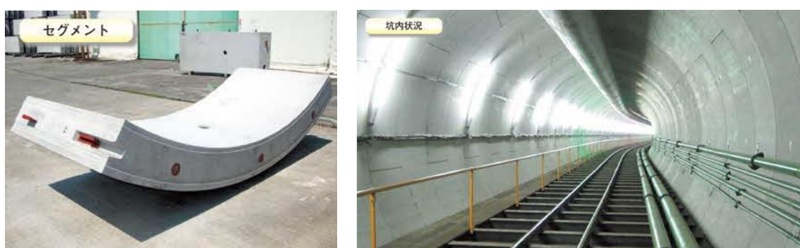
図 4.54 コンクリートセグメント
