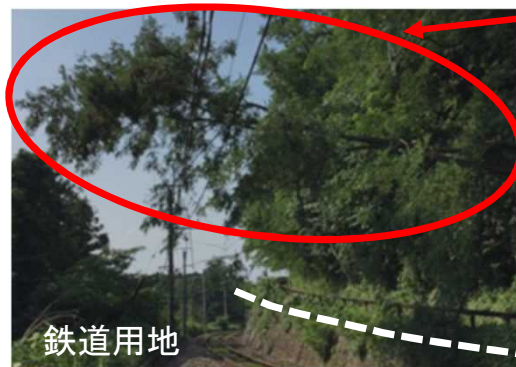
倒木による 線路支障
