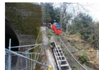
資材運搬のための索道
