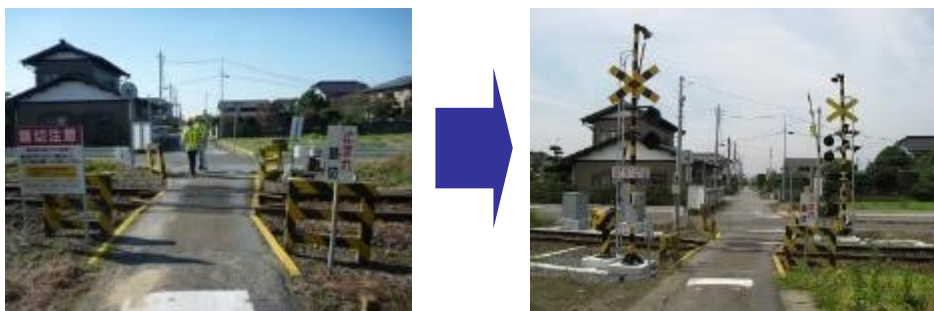
図25：遮断機・警報機の整備
