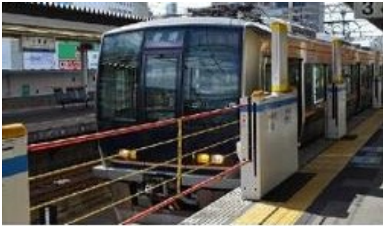
昇降ロープ式ホーム柵
