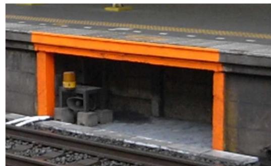
ホーム下の待避スペース
