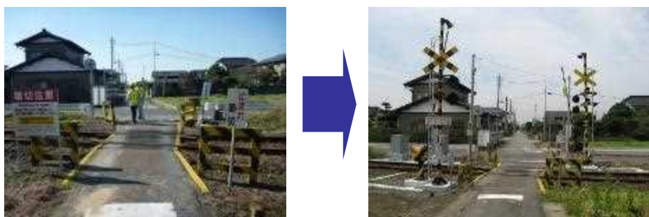
図25：遮断機・警報機の整備
