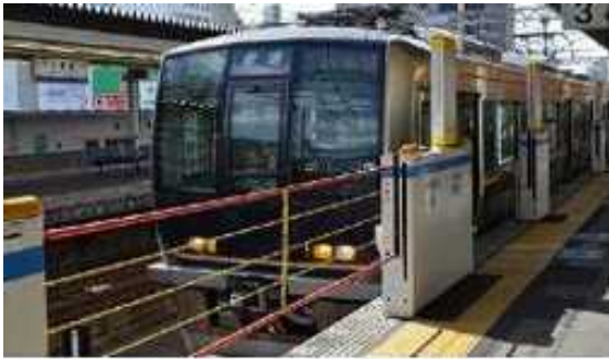
昇降ロープ式ホーム柵
