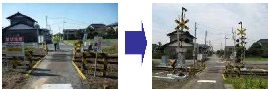
図25：遮断機・警報機の整備
