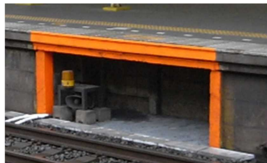
ホーム下の待避スペース
