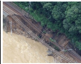
山陽本線の路盤流出の様子
