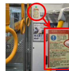
【非常用ドアコック】
