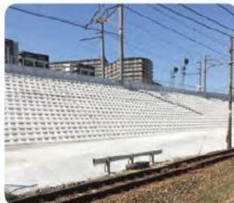
盛土区間の補強
