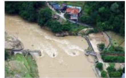
白木山～行留駅間 第1三徳川橋桁流出
