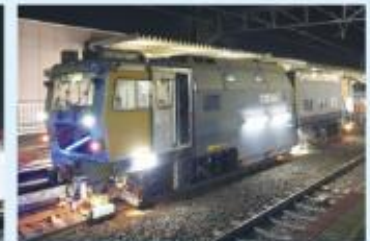
線路のゆがみを直す大型保守用車
