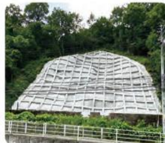
沿線の斜面の補強
