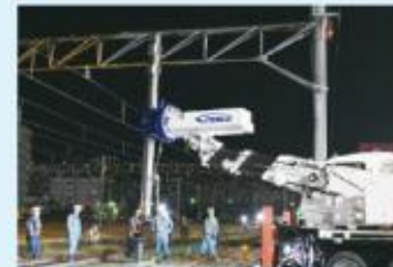
電柱を建てるハンドリング車
