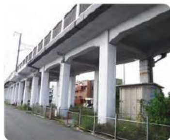
高架橋柱耐震補強
