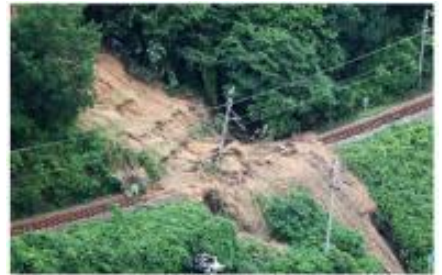
安曇～安曇川河原間 新築崩壊
