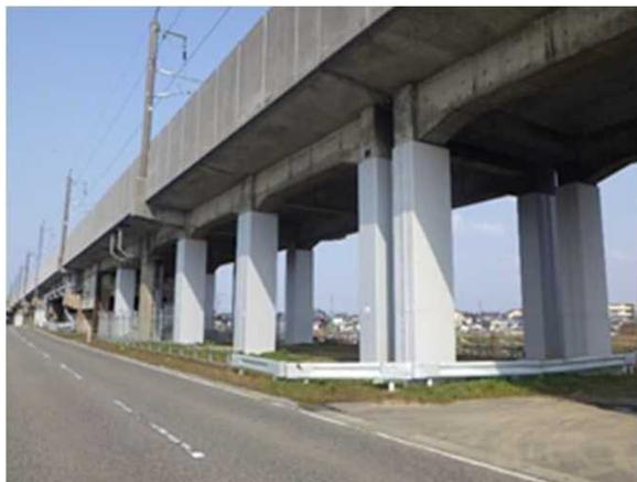
鋼板巻き耐震補強工法
