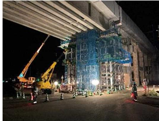
桁および橋台のジャッキアップ
