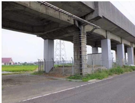
RB(リブバー)耐震補強工法
