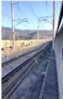
高架橋下層柱の損傷による軌道変位
