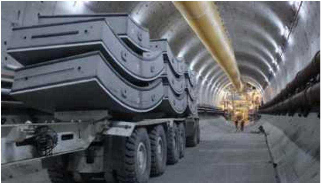
図 4.40 RCライナーの施工状況写真例
