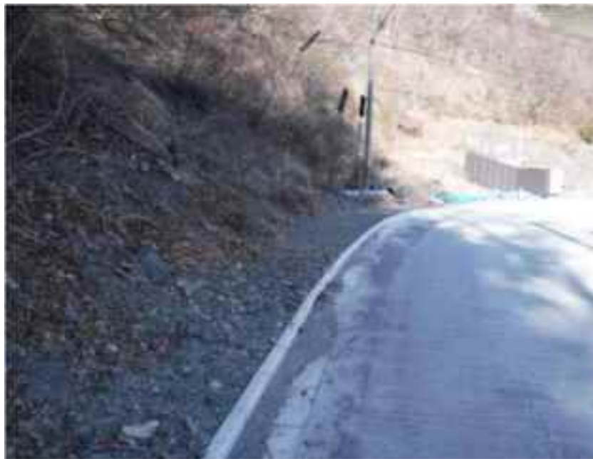
図 4.78 林道東俣線における舗装状況
