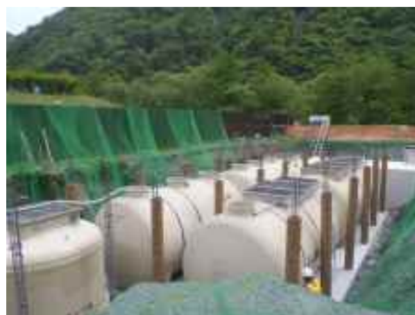
図 4. 7 3 仮設沈砂池（左）、高度浄化装置（右）の設置状況
