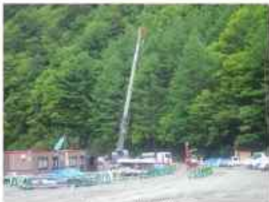
クレーン作業状況
