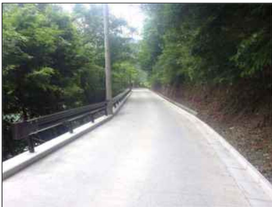
図 9.7 林道東俣線の改良（舗装）
