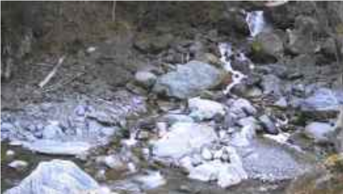
図 4.5 悪沢状況写真 (2021. 12. 10)
