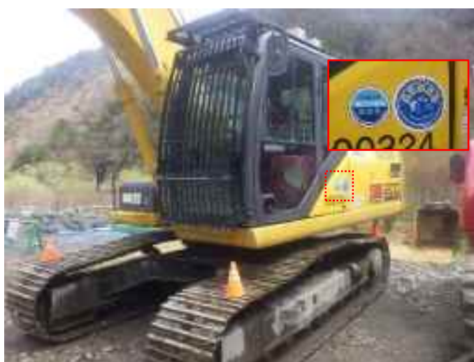
図 4. 7 4 排出ガス対策型、低騒音型建設機械の使用状況
