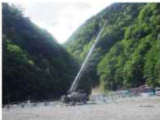
クレーン設置状況
