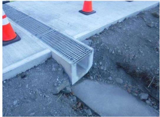
写真 5-1-10(2) 排水溝（側溝、横断溝）の設置状況
