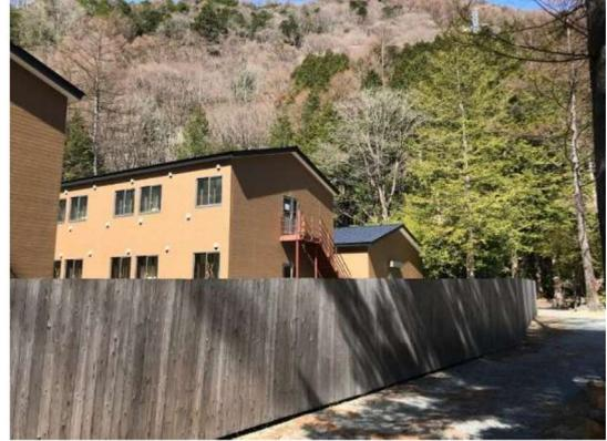
写真 5-1-1(2) 仮囲い（木製）の設置状況
