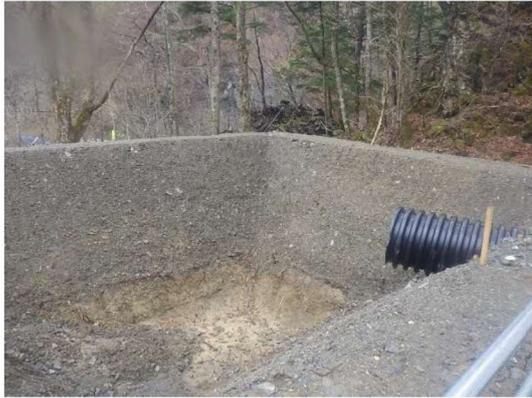
写真 5-1-6 仮設沈砂池の設置状況
