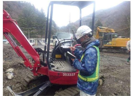
写真 5-1-3 建設機械の点検状況
