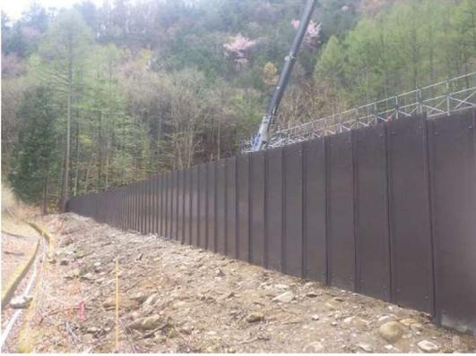
写真 5-1-1(1) 仮囲い（安全鋼板）の設置状況
