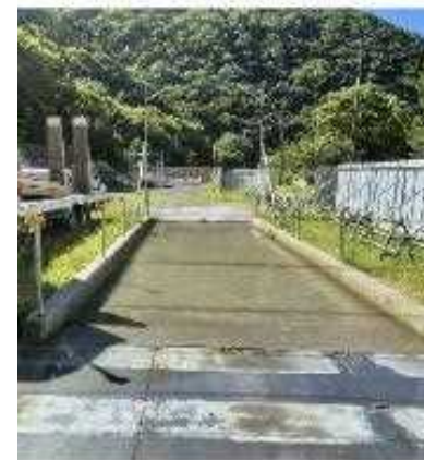
写真 タイヤ洗浄プール (JR東海提供)
