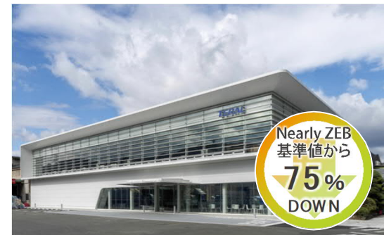
● テラル本社事務所棟
