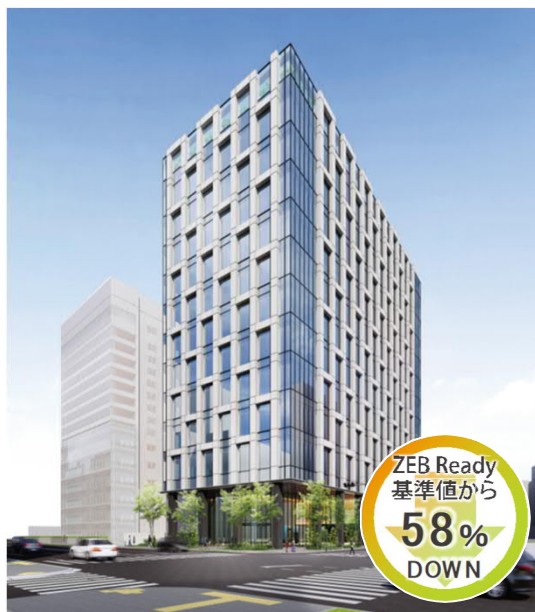
● 港南二丁目計画(施工中)
