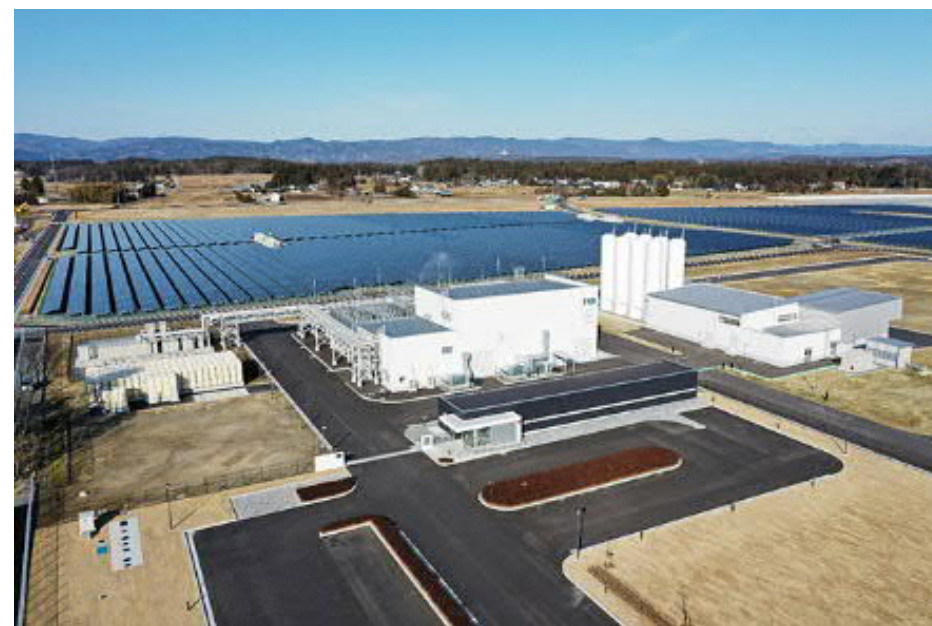
太陽光水素製造プラント (10MW) 福島水素リサーチフィールド (FH2R)
