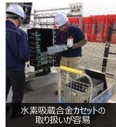
純水素燃料電池で利用 約14.7kWh、8カセット装填
