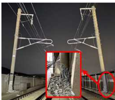
電柱損傷
