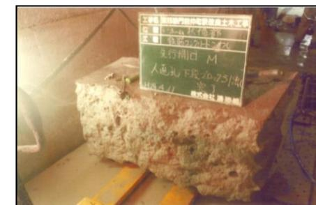
限られた施工空間と施工時間で既設構造物をブロック割りして搬出
